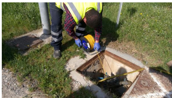
Foto 9: Misura livello di falda nei piezometri di monitoraggio
