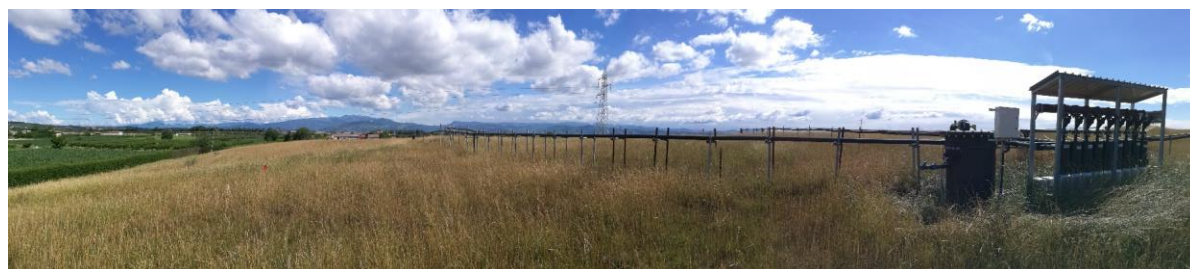
Foto 13: Panoramica della copertura dal lotto 5 verso nord con la rete di captazione biogas e la sottostazione SRC - giugno
