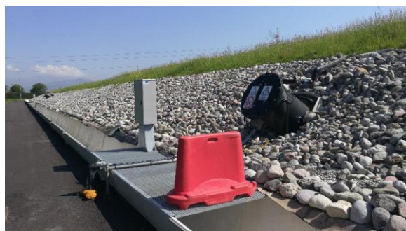
Foto 6: Sponda ovest e pozzo captazione percolato n.4 - maggio
