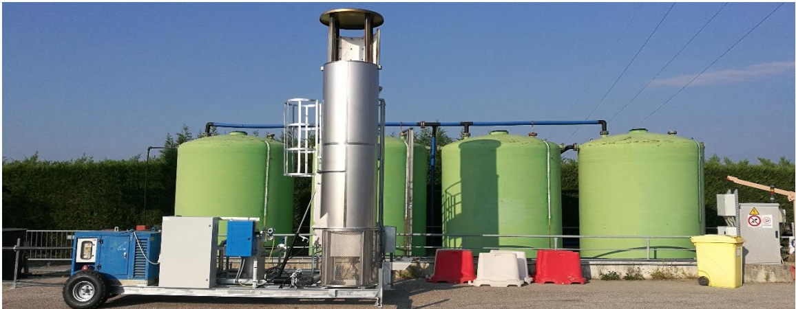
Foto 14: Serbatoi per lo stoccaggio del percolato emunto dalla discarica – In primo piano torcia T2
