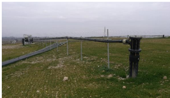
Foto 5: Verifica pendenze rete di collettamento biogas - febbraio
