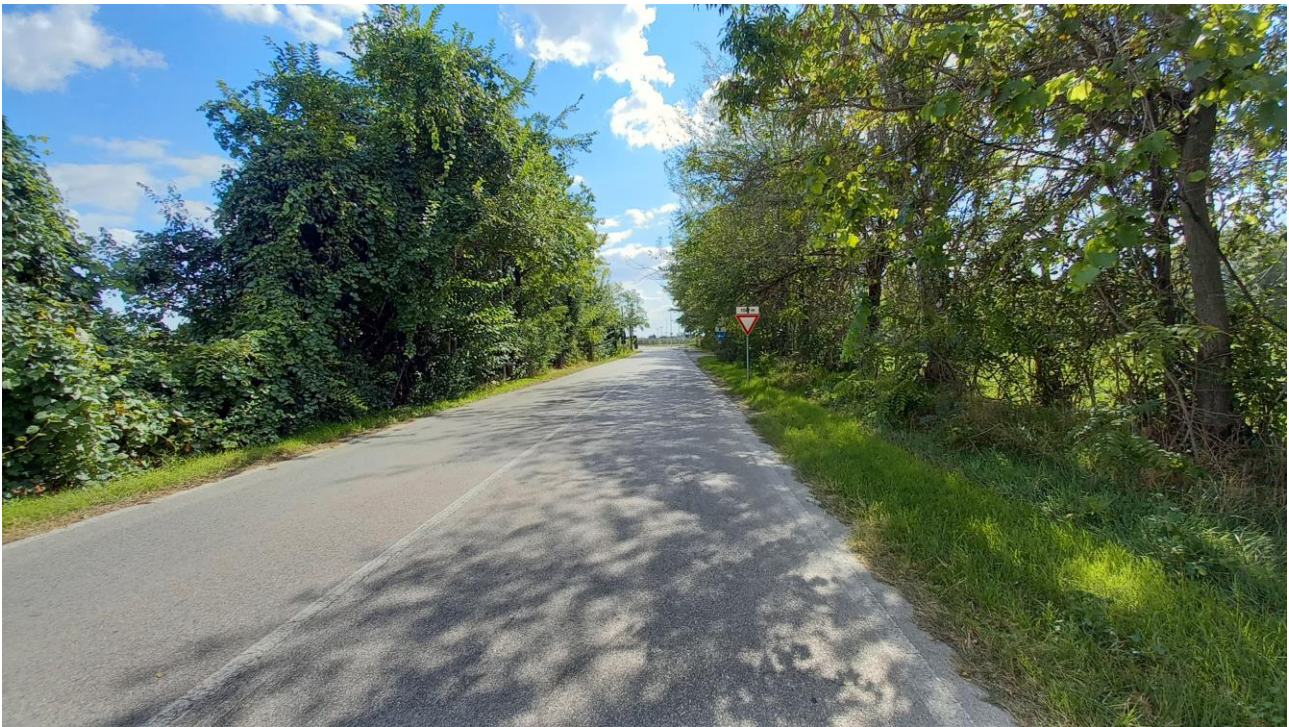
Foto n.3 – Via Rampa vista verso sud
