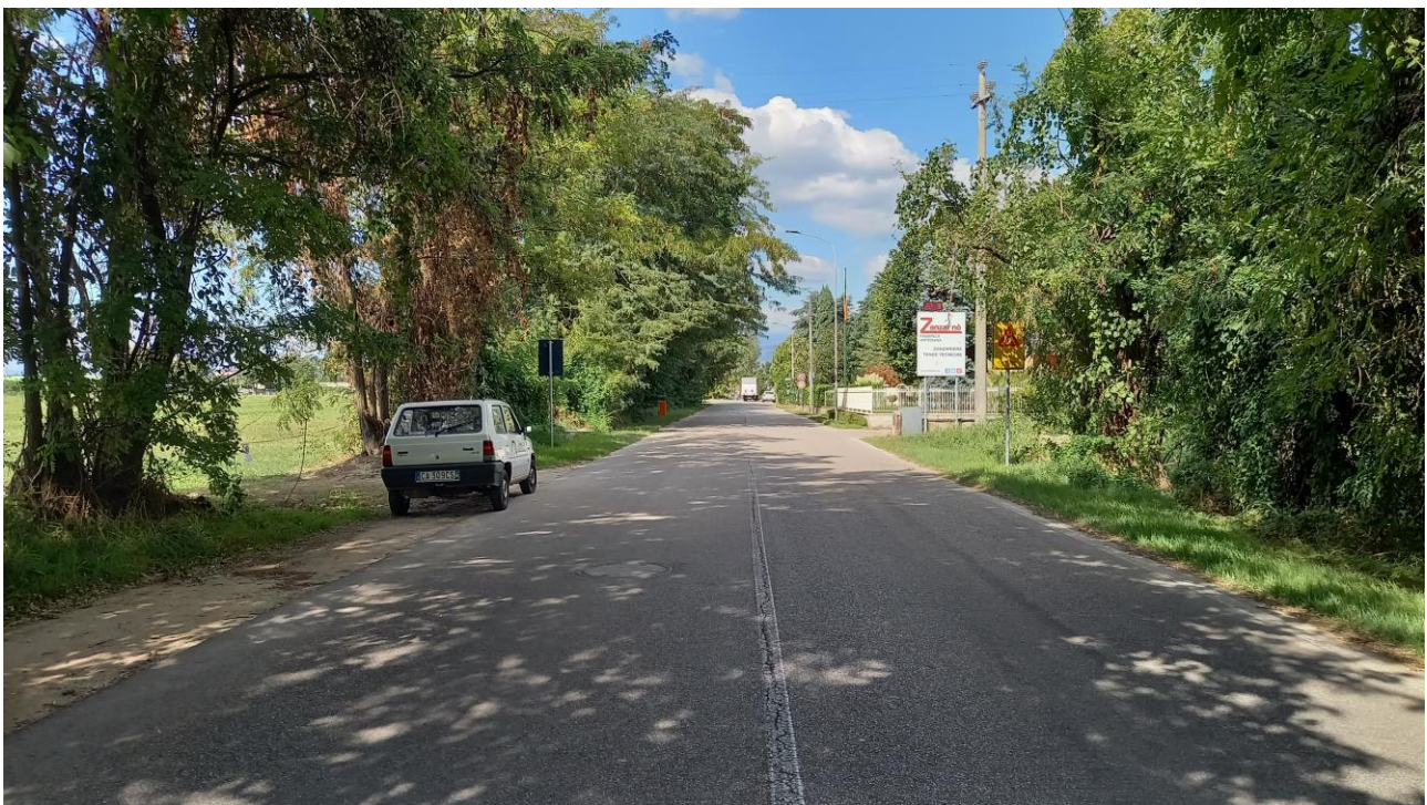
Foto n.4 – Via Rampa vista verso nord
