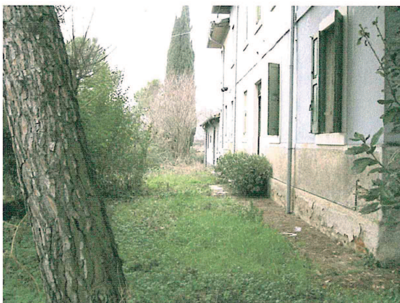
FOTO 1. Prospetto ovest, corpo centrale.
