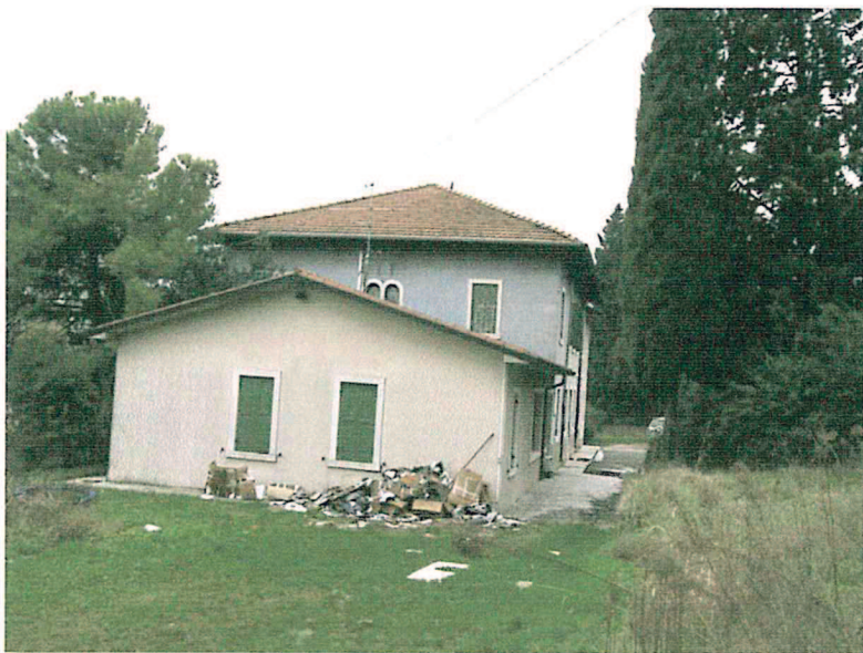
FOTO 3. Prospetto nord, ampliamento.
