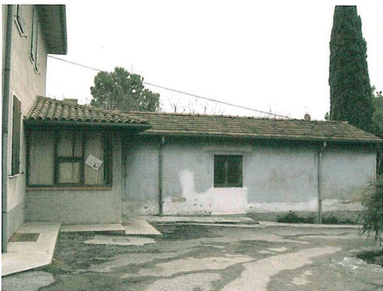
FOTO 4. Prospetto ovest, lato accesso.
