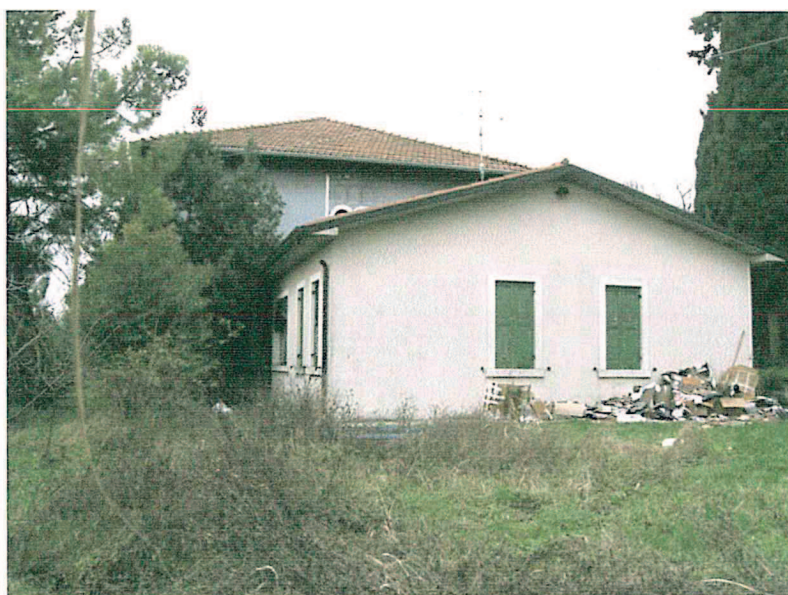
FOTO 2. Prospetto nord, ampliamento.
