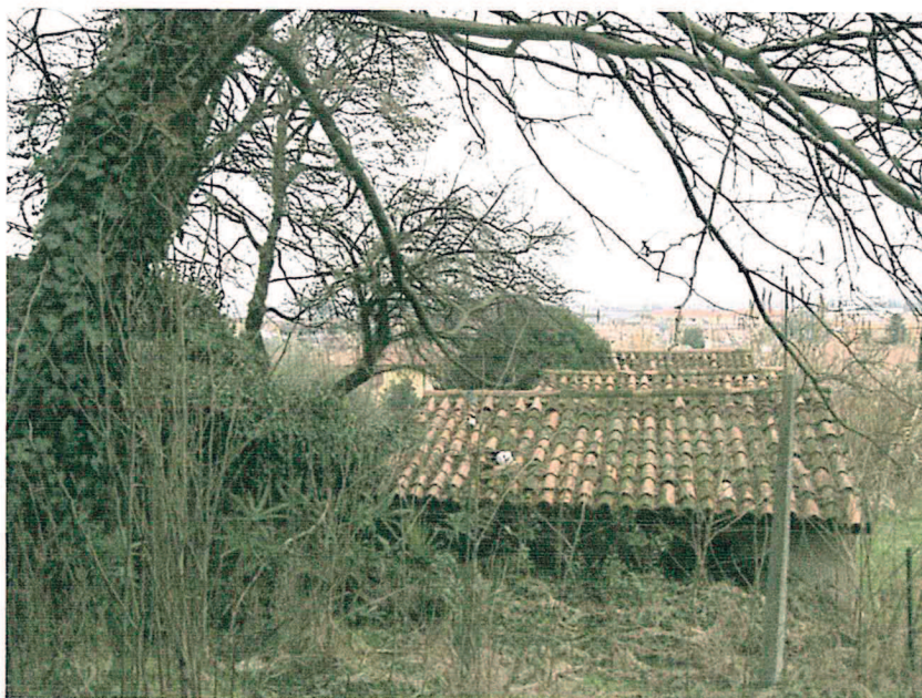
FOTO 2. Prospetto sud, deposito.
