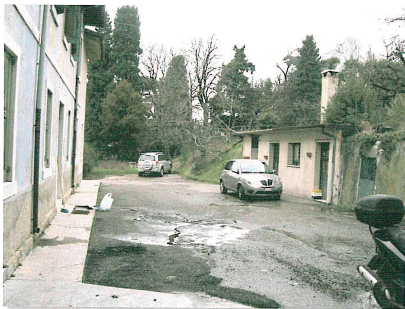
FOTO 1. Prospetto lato nord, accessorio.
