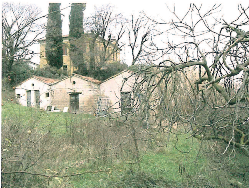
FOTO 1. Prospetto sud, deposito.
