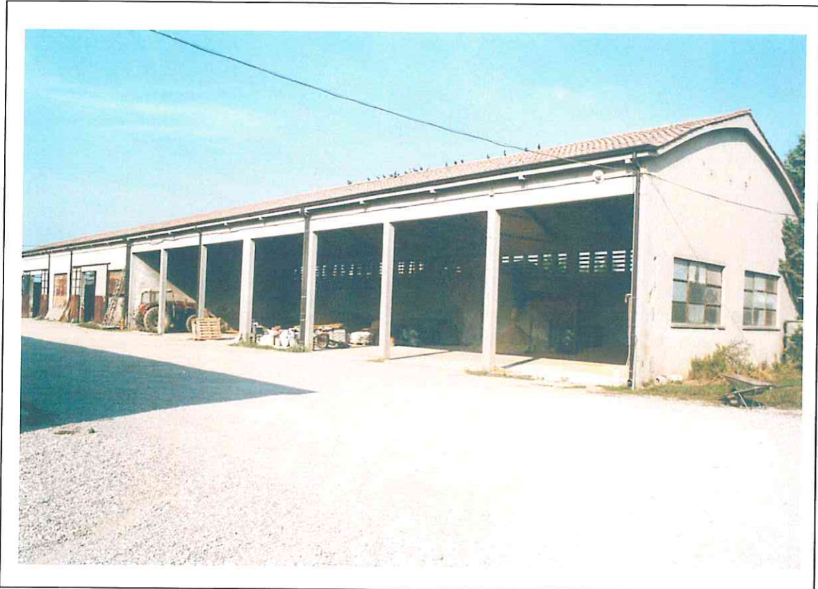
1) Vista portico lato SUD - OVEST
