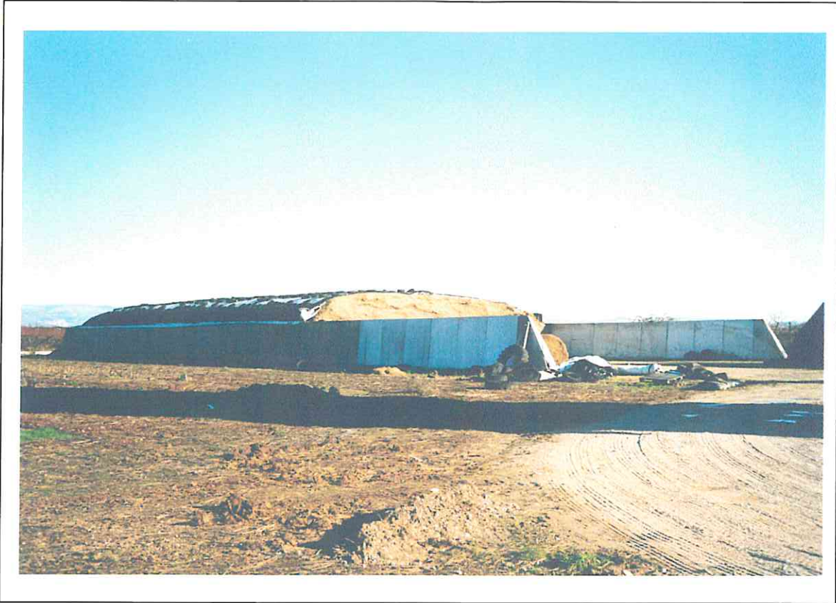
1) Vista vasca trinciato fuori terra lato SUD - OVEST
