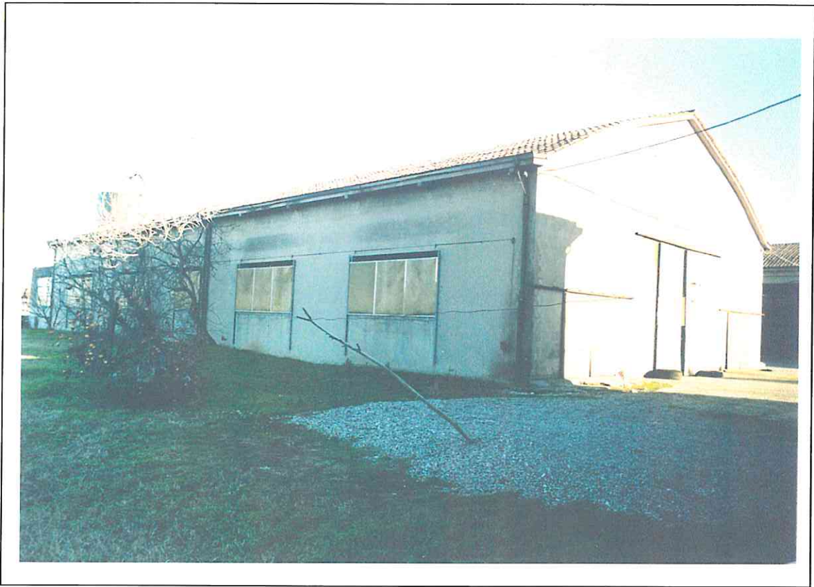
1) Vista stalla lato SUD - OVEST
