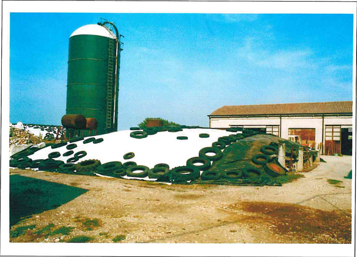
1) Vista manufatto da SUD-OVEST
