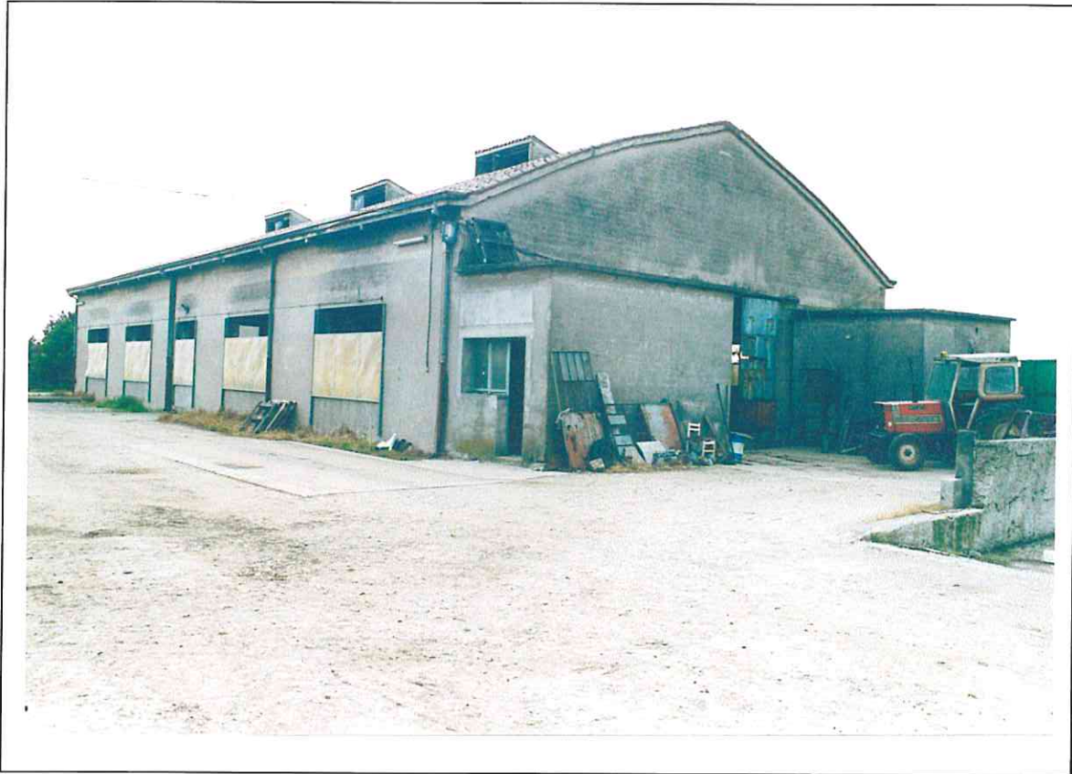
1) Vista pesa con locale annesso lato NORD
